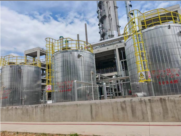
装置区、罐区、污水处理等区域硬化防渗措施
