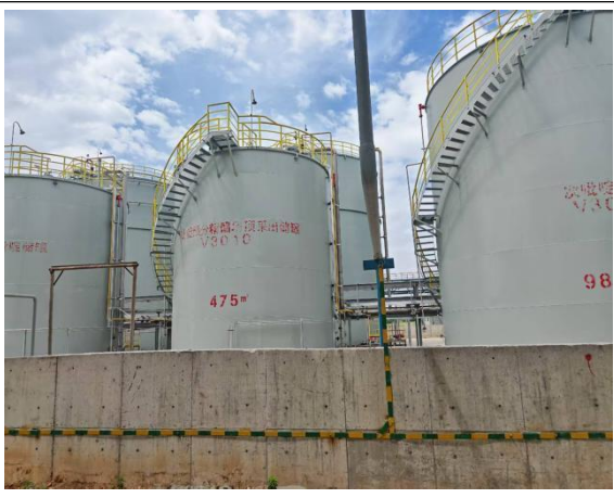
装置区、罐区、污水处理等区域硬化防渗措施
