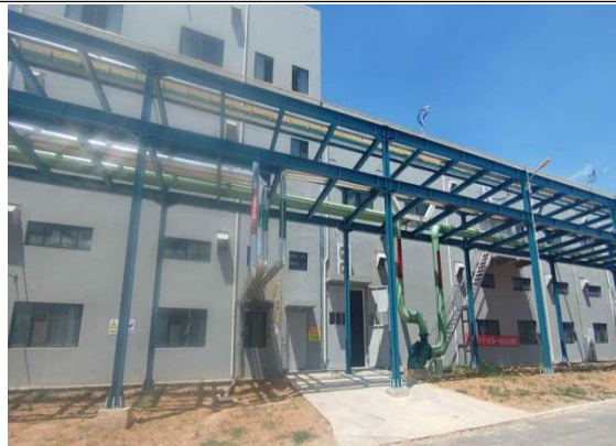
乙醛水处理站
